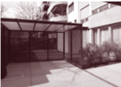
Burgfelderstrasse 18 mit neuen Velounterstand und Aussenbereich
