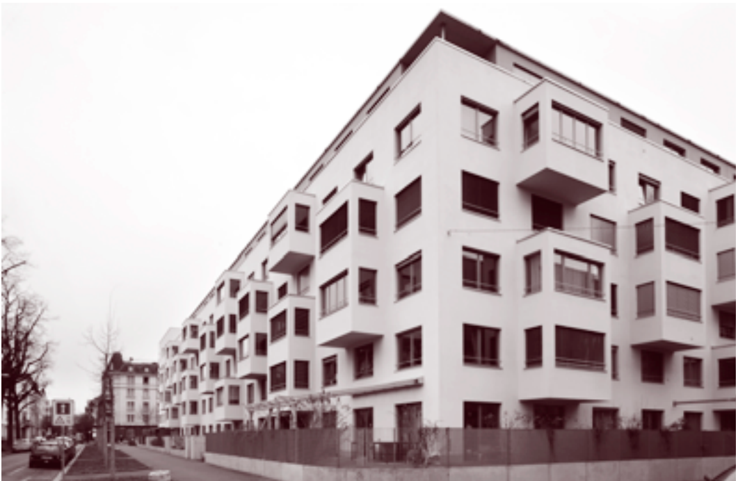
@home, Wohnhaus für 20 schwerbehinderte Menschen
