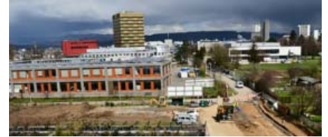
Rechts entsteht der neue Fussgänger- und Fahrradweg.
