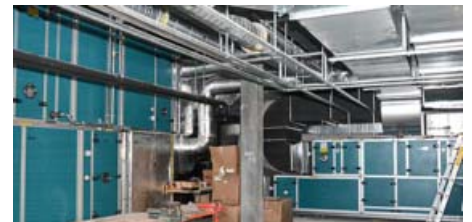
Haustechnikzentrale im UG. (Fotos: Corine Köhli)
