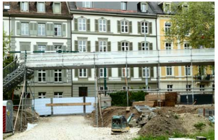
Zugang Kindergruppen über Behelfsbrücke.
