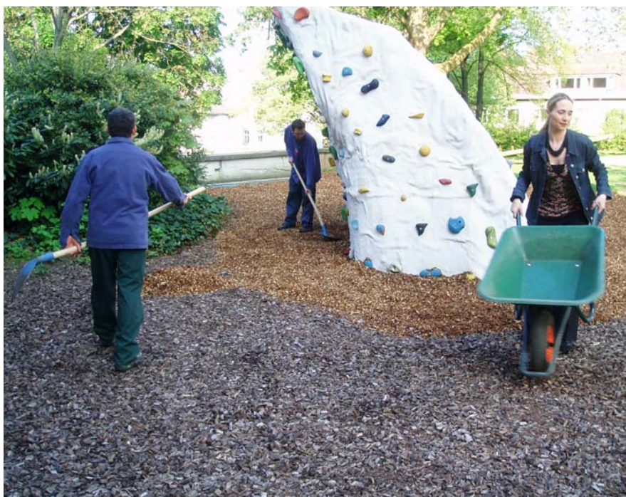
Neuer Belag rund um den Kletterfelsen.
