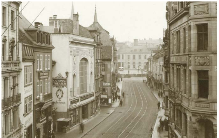
Die damals neue Falknerstrasse, Blick von der Hauptpost in Richtung Barfüsserplatz © Staatsarchiv Basel-Stadt, nach 1900, AL 45, 5-41-2
