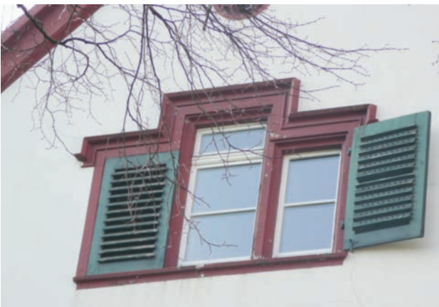
Fenster Fruchtschütte, Räume der familienergänzenden Tagesstruktur/Mittagstisch
