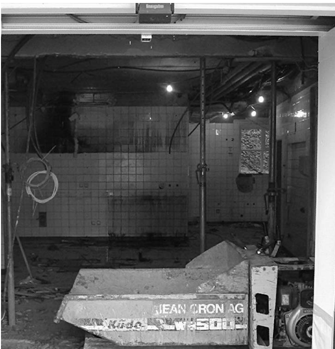
Foyer während des Baus.
