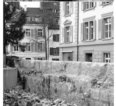
«Mauerfall» im Waisenhaus. Temporäre Öffnung der Mauer für den Abtransport.
