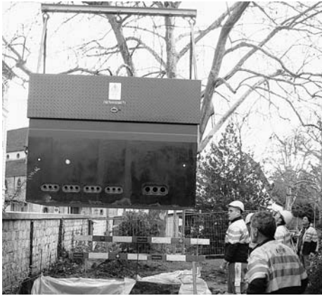
Die neue Trafostation wird installiert. Die Anlage verteilt den Strom in die Kartaus- und einen Teil der Utengasse sowie der Riehen- torstrasse und natürlich ins Waisenhaus.
