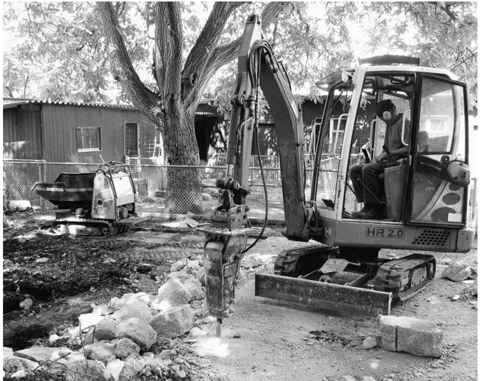
Abbruch des Maschinenschuppens und der Kompostanlage.
