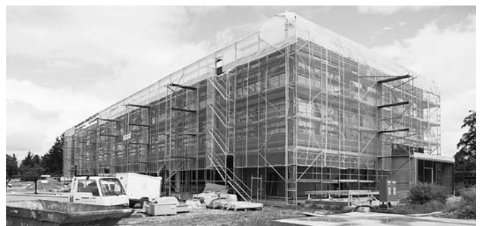
Das Verwaltungsgebäude im heutigen Kleid.
